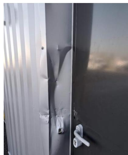
Photo 2\_ Dégâts limités suite au forcement des accès.
