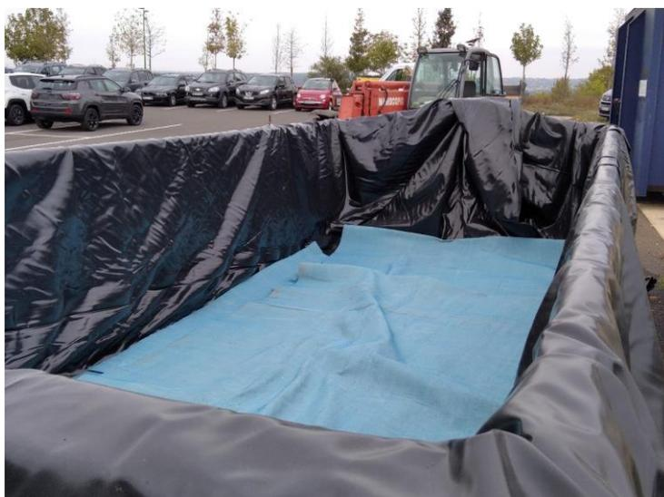
Photo 11\_ benne étanchéifiée 3 jours après le sinistre, bâche de 0.5mm et moquette
